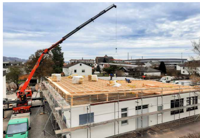
März 2023: Errichtung PV-Anlage auf dem Betriebsgebäude der Stadtwerke
