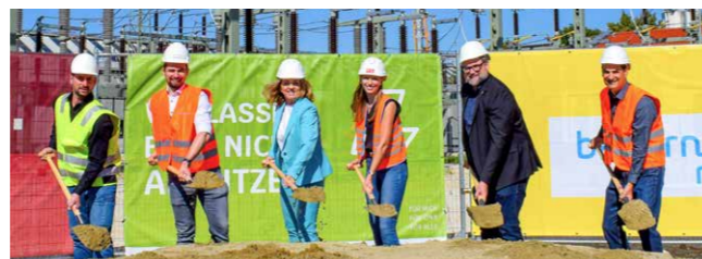
September 2023: Spatenstich Schaltanlage Umspannwerk Saal
