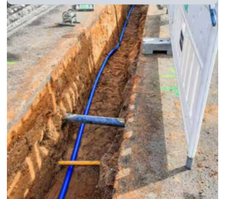
Mai 2023: Wasserhauptleitung Posener Straße
