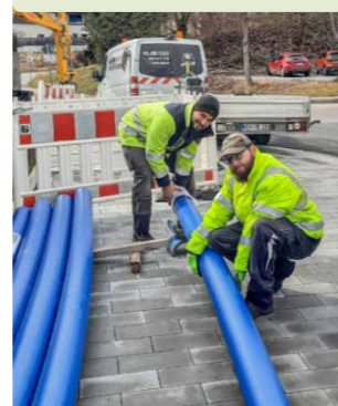
März 2023: Wasserhauptleitung Hohenpahlweg
