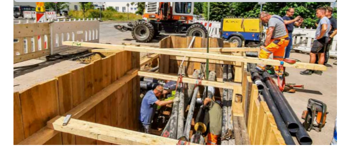
April 2023: Beginn Ausbau Fernwärmenetz Klosterstraße
