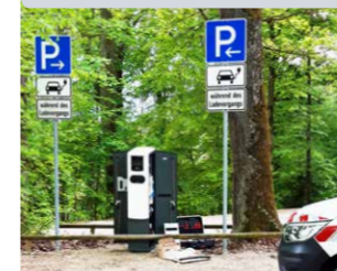
Mai 2023: Aufstellung Ladesäule am Parkplatz der Befreiungshalle Kelheim
