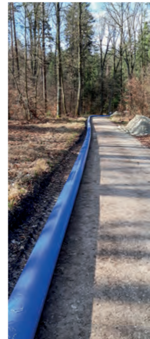
April 2020: Baustelle Wasserverbindungsleitung Weltenburg - Kelheim
