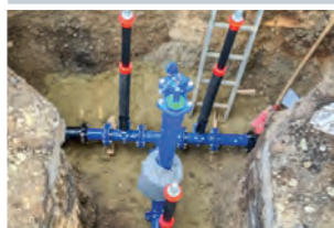
September 2020: Baustelle Bojerstraße-Flurstraße
