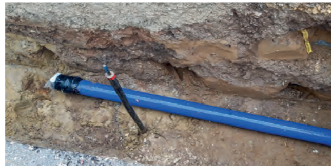
März 2020: Baustelle Wasserhauptleitung Hallstattstraße
