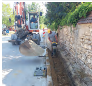
August 2020: Baustelle Trassenerweiterung Breitband im Hohlweg
