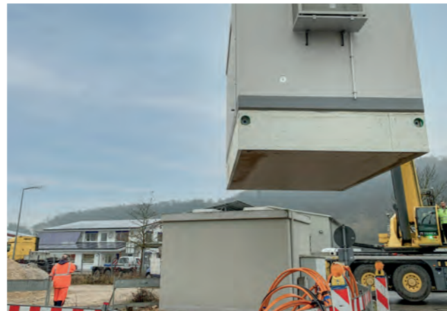
Januar 2020: Glasfaserausbau Inbetriebnahme POP Kastlacker
