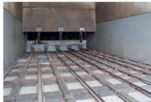
Juli 2020: Revision Biomasseheizkraftwerk
