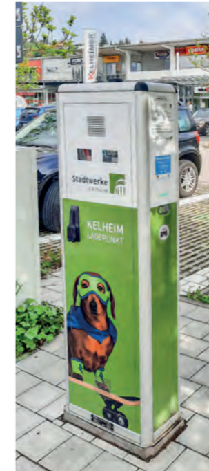
Mai 2020: Inbetriebnahme Ladesäule am Einkaufscenter Kelheim
