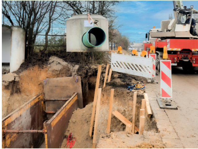
Januar 2022: Errichtung Löschwasserbehälter Winzerberg
