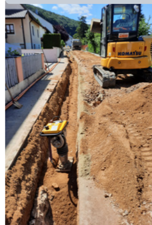
August 2022: Wasserhauptleitung Altwaterstraße
