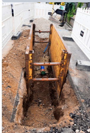
Juli 2022: Trinkwasser- hauptleitung Prälat-Meindl-Straße
