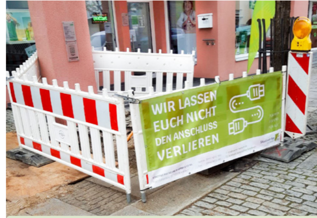
Januar 2022: Glasfaseranschluss Altmühlstraße
