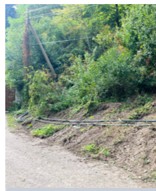
September 2022: Teilverkabelung Klösterleitung
