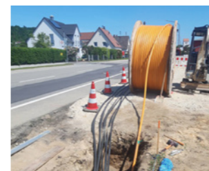
Mai 2022: Strom- und Glasfaserleitung Baugebiet Sandfeld
